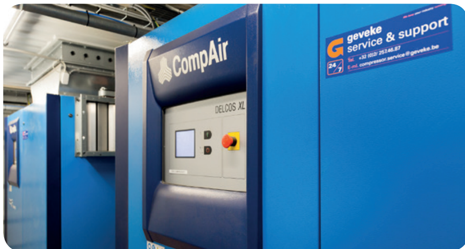
De CompAir toerengeregelde schroefcompressor is precies geschikt voor de meest gevraagde capaciteit, waardoor de compressor nagenoeg constant in zijn efficiënte bereik draait.
